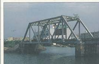
⑧港一・二号橋梁 (明治40年・鋼トラス橋) 大岡川河口付近の新港連絡線(現・横浜博覧会臨港線)に架かる100フィート2連のトラス橋は、1907年アメリカン・ブリッジ社製であり、クーバー型といわれる米系トラスの遺構。
