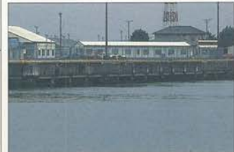
⑥瑞穂埠頭 (昭和4~10年・鉄筋コンクリート躯体) 瑞穂埠頭の岸壁には昭和初期の港湾土木技術が集中的に投入されている。明治期に築造された新港埠頭石積岸壁との比較が楽しめる。
