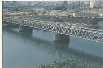
⑫大岡橋梁 (昭和3年移設・鋼ワーレントラス橋) 北海道炭鉱鉄道夕張線の夕張川橋梁と総武鉄道江戸川橋梁を補強のうえ移設したもので、現存最古の鉄道橋である。六郷川橋梁と同タイプの100フィート英国系トラスである。
