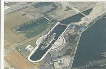
⑩旧横浜船渠石造ドック (明治29~32年・相州堅石積) 1号ドック・2号ドックは、第1次横浜築港の一環として計画された修船施設。わが国固有の本格的石積ドックである。(詳細はP3)
