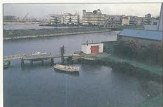
⑪旧灯台繋留岸 (明治2年)と波止場突堤 (明治6年・石積) 大岡川右岸に残る旧灯台繋留石積護岸は、横浜では最も古い河川護岸である。また現第三管区海上保安本部構内(旧灯台繋留)には、横浜のまちづくりに大きな足跡を残したプラントンゆかりの突堤跡が現存している。
