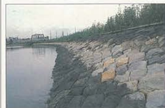
⑦新港連絡線鉄道線路護岸 (明治43年?・割石練積) 谷積石垣が鉄道関係築造技術の系譜を物語っている。護岸の傾斜のびやかでヒューマンな表情がいい。
