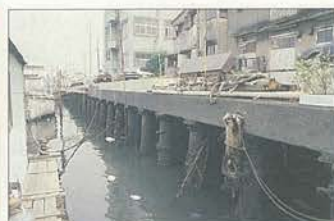
⑮旧6号物揚場 (大正14年・鉄柱、鉄筋コンクリートスラブ) 関東大震災後の震災復興施設。横橋方式の物揚場であり、創設時の大橋橋で使われていたスクリーバイルが今も使用されている。
