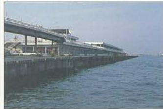
①横浜港大橋 (明治27~29年・鉄造) 第1次横浜築港工事で製造され、繋船岸壁出現以前の中心的繋留施設である。現在の国際旅客ターミナル(昭和30年)は橋樑上屋の3代目にあたり、今なお横浜港の象徴的存在となっている。
