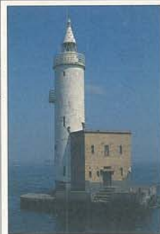
⑤横浜港外防波堤灯台 (昭和14年・鉄筋コンクリート)
