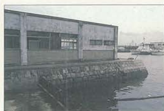
⑯旧7号護岸 (大正13年~慶応年間創建) 象の鼻とともに、幕末期イギリス波止場の港域を示す遺構として貴重なものである。
