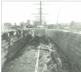
水抜きされた一号ドック
