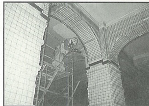
コンクリートの再アルカリ化工事
