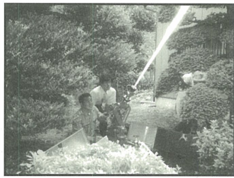
設置された放水銃
