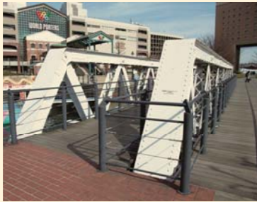
港三号橋梁 (旧大岡川橋梁)
