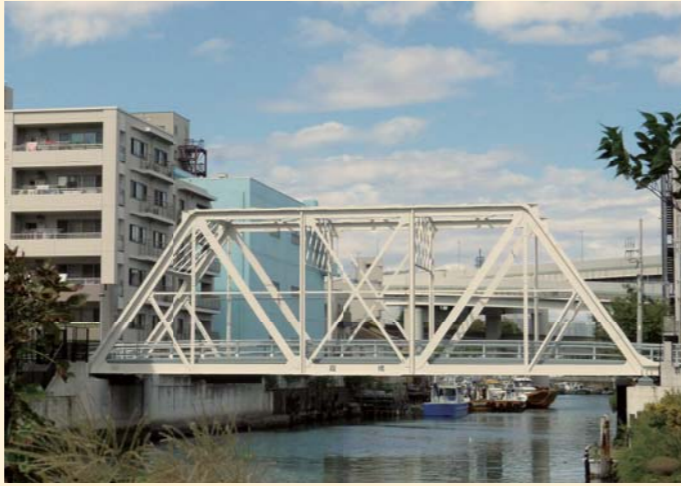
霞橋 (旧江ヶ崎跨線橋) 橋長:約32.9m
