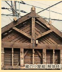
蔵の小屋組(解体時)
