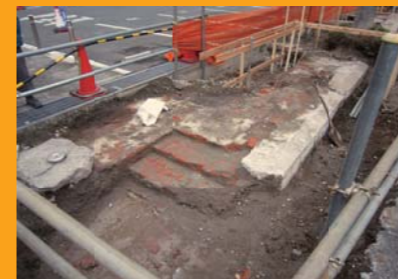
工事中に見えられた基礎遺構
