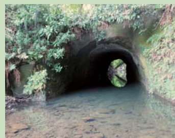
いたち川河川隧道の入口
