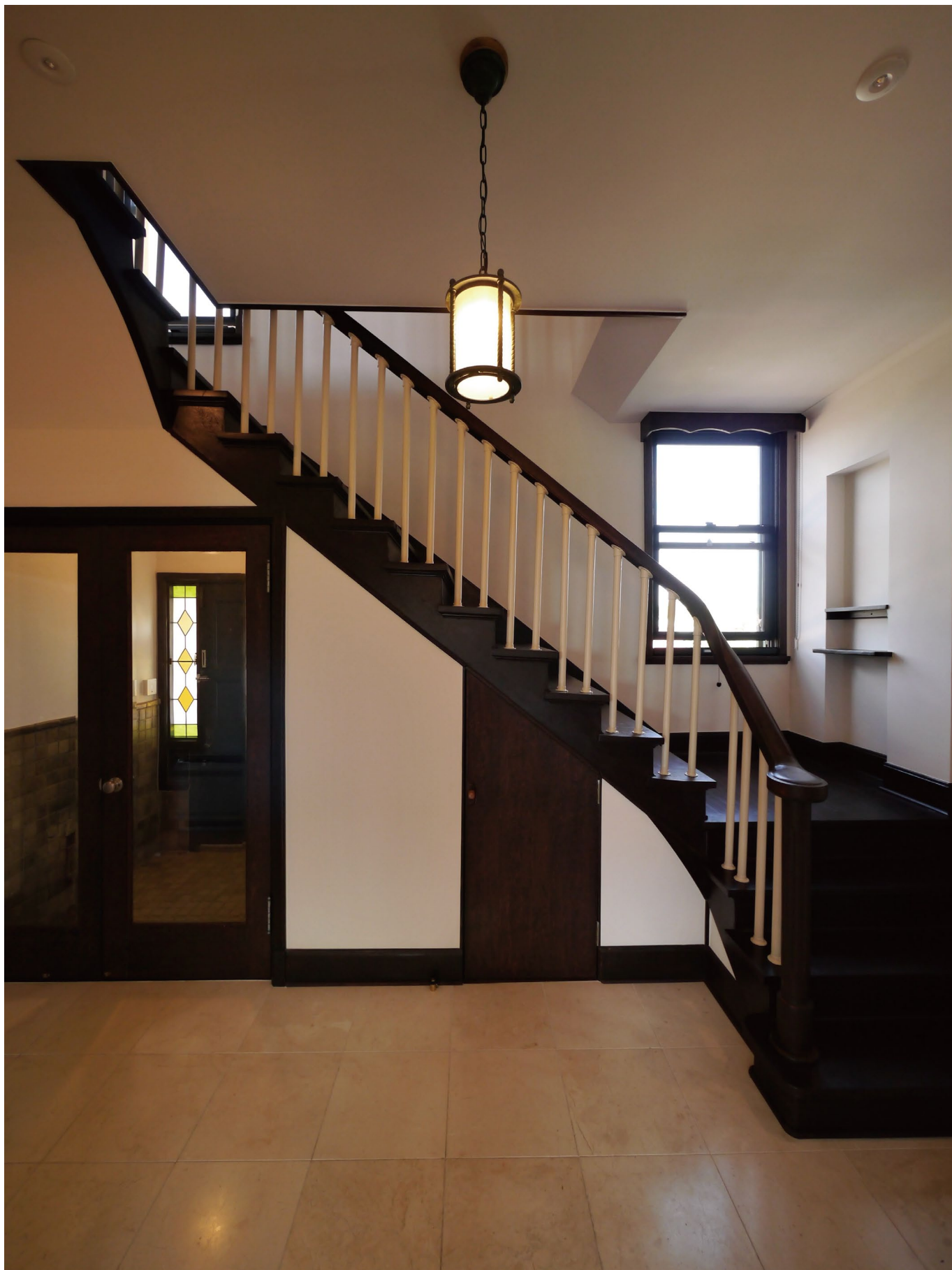
一階玄関横の階段 照明器具は竣工当初の器具をリペアして使用している
