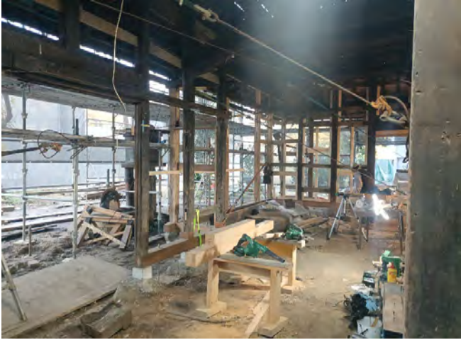
▲池谷家 工事の様子(外壁改修)
