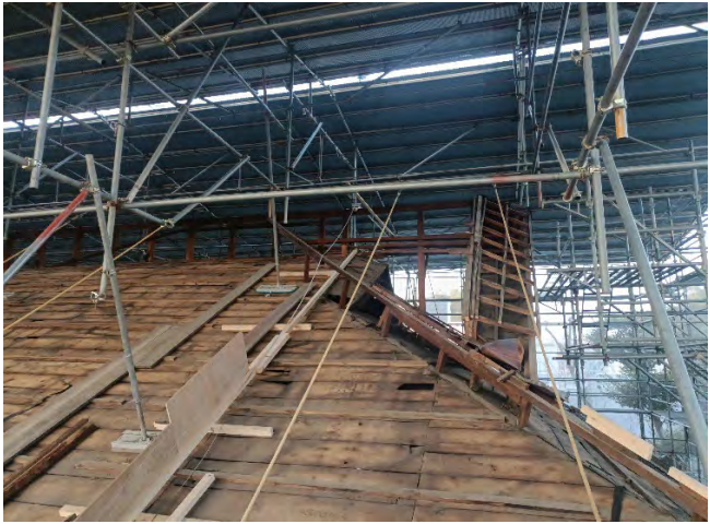
▲池谷家 工事の様子(屋根改修)
