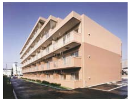
第1期改良住宅
