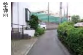
狭い道路拡幅整備（唐沢）
