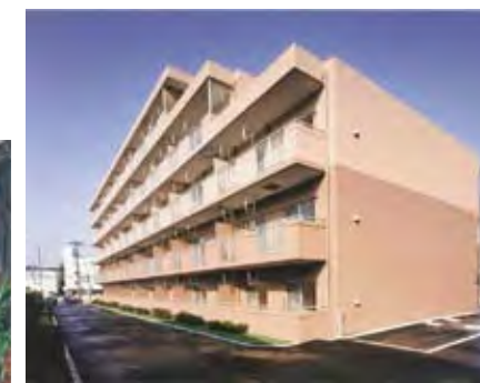
第1期改良住宅
