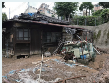
老朽建築物を解体し、 防災広場を整備した例
