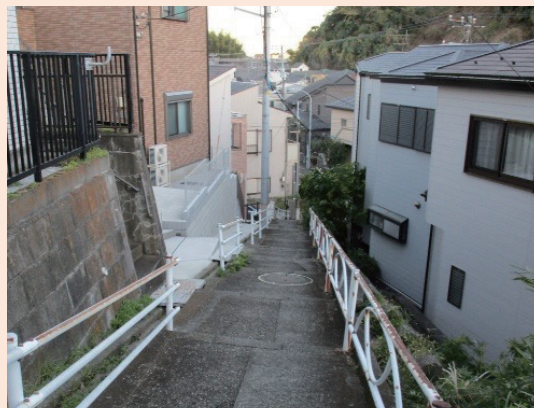
階段に沿って密集した建物
