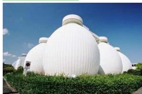
「環境創造局・汚泥資源化センター消化タンク」
