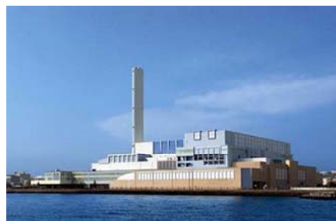
「資源循環局・金沢工場」
