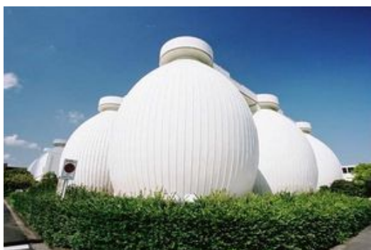
「汚泥資源化センター・消化タンク」
