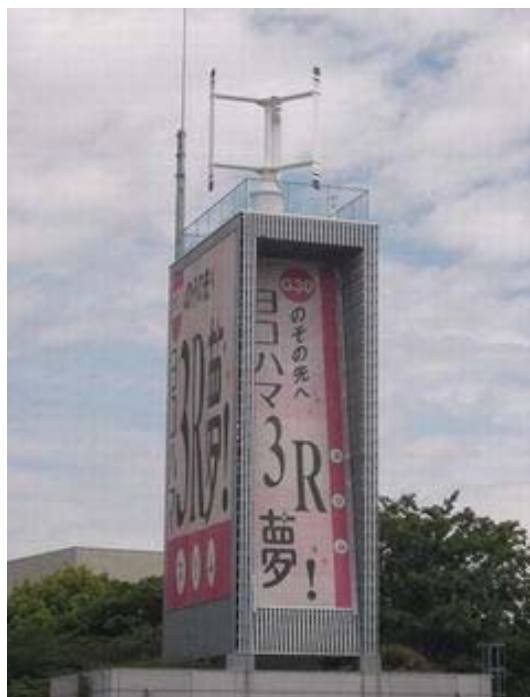
「資源循環局港北事務所・風力発電設備」
