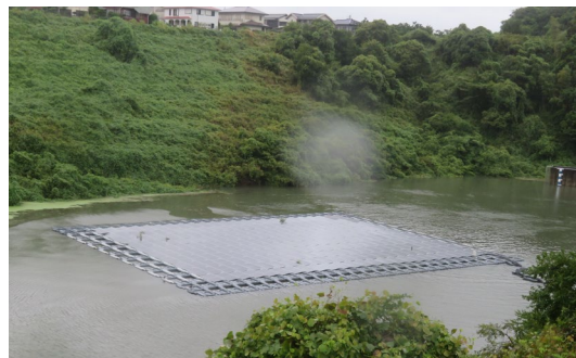
フロート式太陽光発電（雨水流入時）
