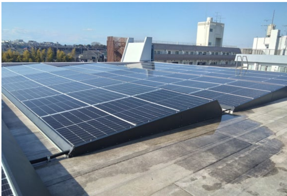
区役所屋上への太陽光発電設備設置
