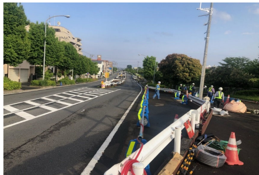
ガードレール移設・電気引き込み等工事
