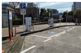
都筑区センター南駅広場 公道充電ステーション
