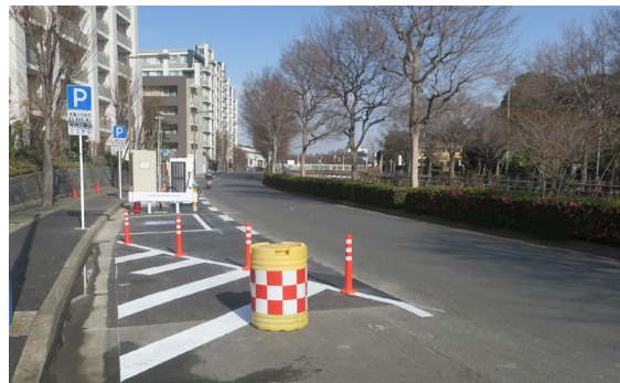
充電ステーション
