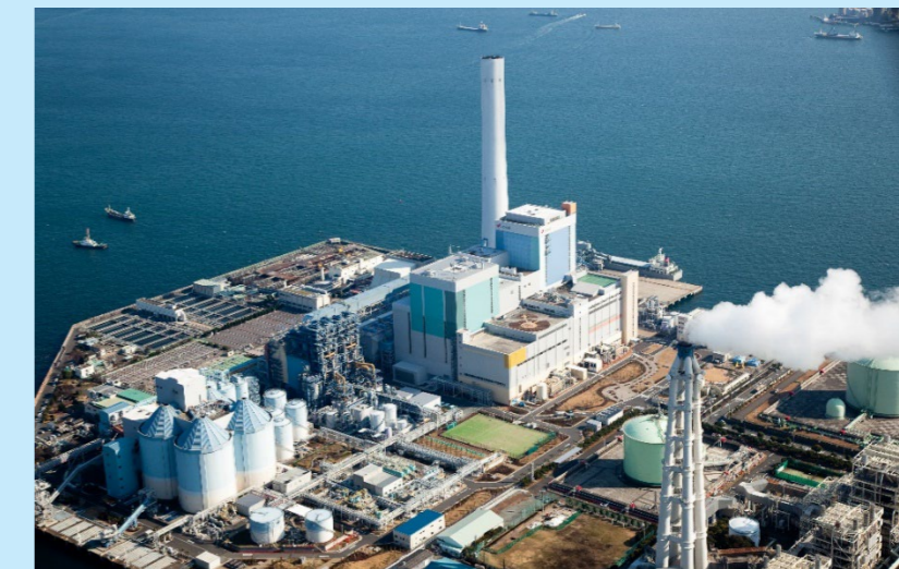
磯子火力発電所の外観
