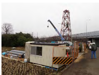
【写真】井戸掘削の様子（緑区）
