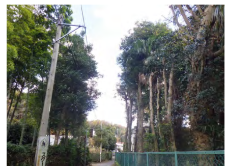
【写真】 作業前（上）と作業後（下）（戸塚区）
