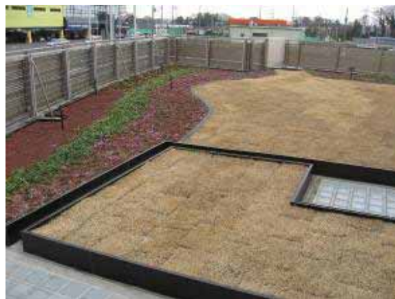
【写真】 地域で緑化計画を策定し緑化した 公共施設の屋上緑化
