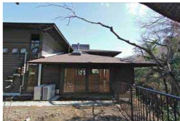
【写真】自然観察センター増築箇所
