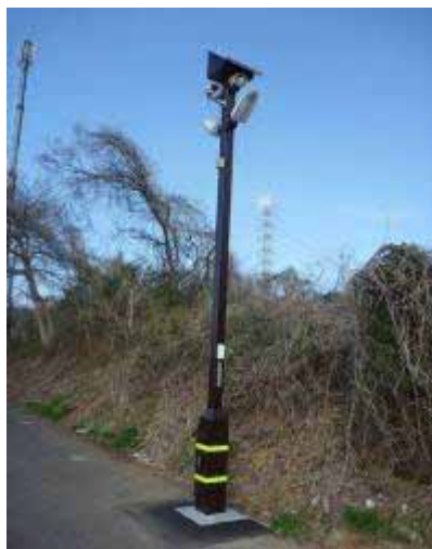
【写真】不法投棄監視警報装置の様子(都筑区)
