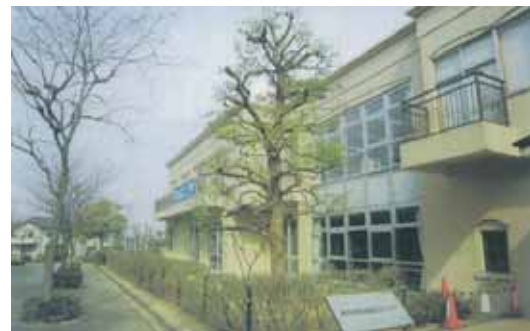
【写真】せん定後のクスノキ (都筑区/中川西地区センター)
