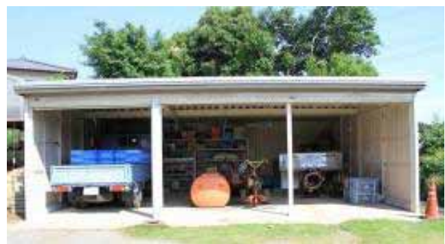
【写真】農業機械格納庫(泉区)
