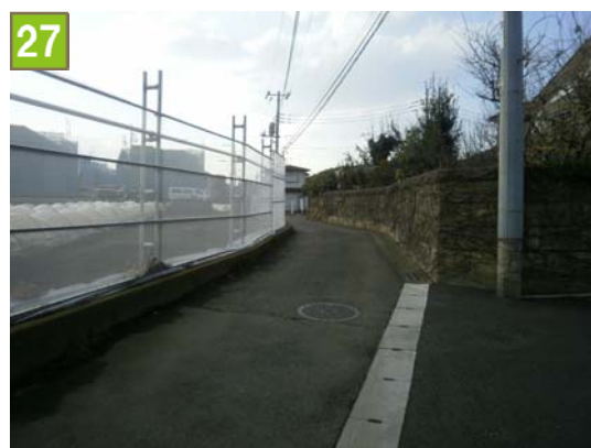
27 環境配慮型施設整備事業[農薬飛散防止ネットの設置]（長津田町）
