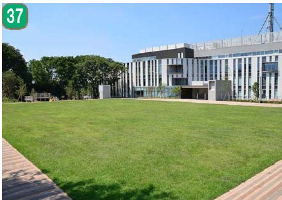
37 公共施設緑化事業 (瀬谷区総合庁舎)
