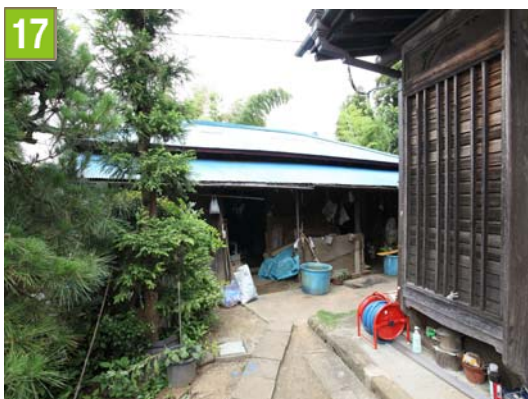
特定農業用施設保全事業 (笹下二丁目)
