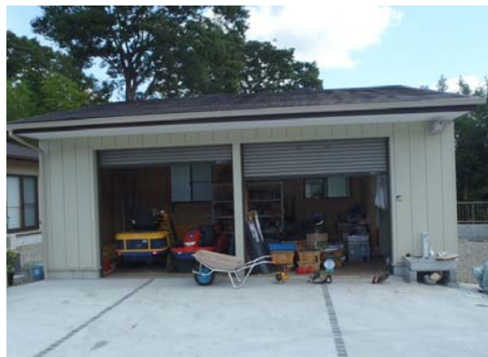
【写真2】農業用倉庫 (旭区)
