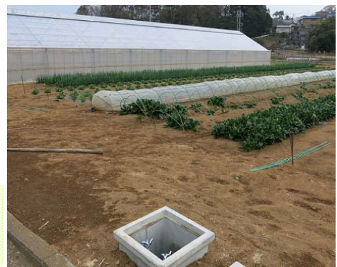
【写真】配管整備（水栓柙設置） (戸塚区、堤ヶ谷地区畑地かんがい施設利用組合)
