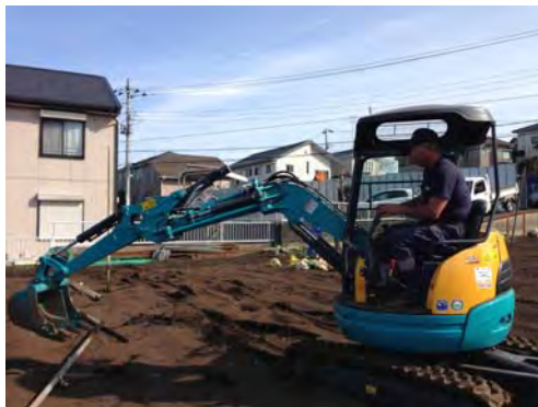
【写真】リース方式により導入したバックホーによる耕耘作業
