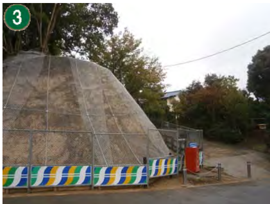
緑地再生等管理事業[市民の森等の斜面地での防災対策工事]（獅子ヶ谷市民の森）
