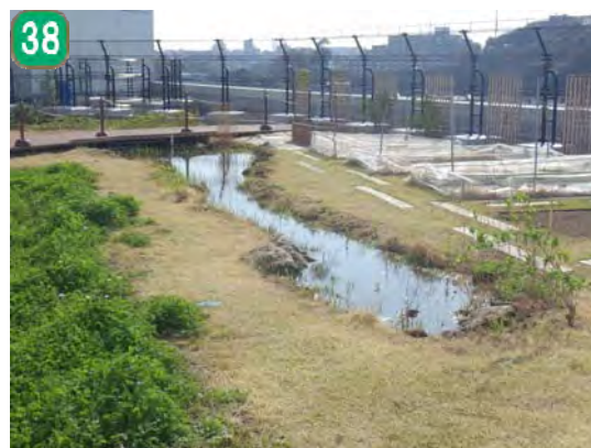
38 公共施設緑化管理事業 (戸塚区総合庁舎)
