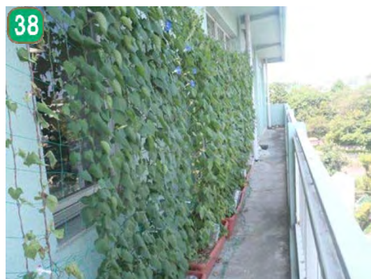
公共施設緑化管理事業（栄区役所）
