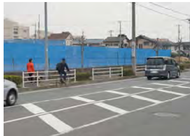
【写真】農薬飛散防止ネットの設置例 畑からの農薬の飛散を抑えられ、歩行者等が安心して通行できます。
