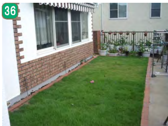
36 民有地緑化助成事業[屋上緑化等助成事業] (上柏尾町)
