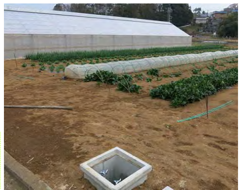
【写真】配管整備（水栓柙設置） (戸塚区、堤ヶ谷地区畑地かんがい施設利用組合)
