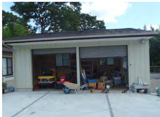
【写真2】農業用倉庫 (旭区)
