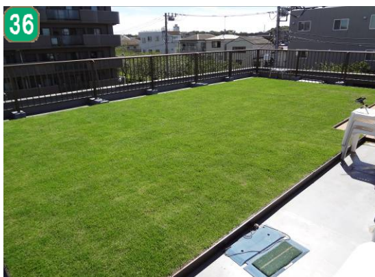
屋上緑化等助成事業（新羽町）
