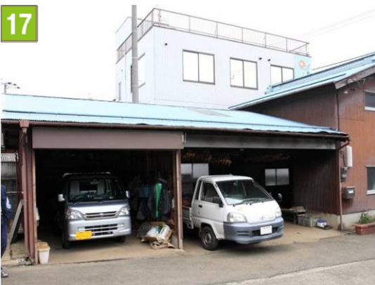
17 特定農業用施設保全事業（新羽町）
