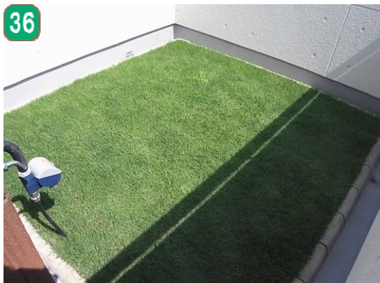
屋上緑化等助成事業（川和町）
