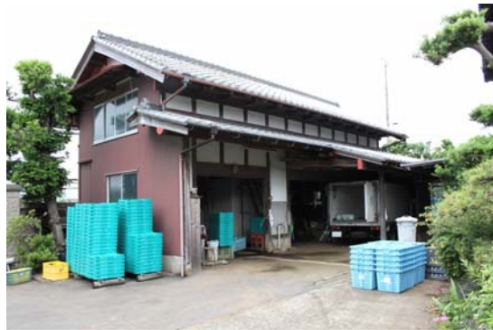
【写真 2】作業場兼倉庫（戸塚区）
