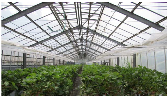
【写真】保温カーテンを設置した温室
