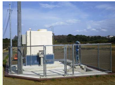
【写真】電気設備及び貯水槽整備 (緑区、向原地区畑地かんがい組合)
