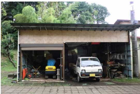
【写真 1】農業機械格納庫（旭区）
