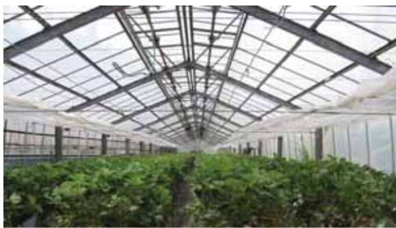
【写真】保温カーテンを設置した温室
