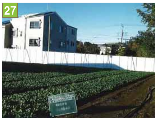
27 環境配慮型施設整備事業（池辺町）
