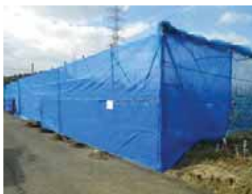
【写真】 農薬飛散防止ネットの設置事例
