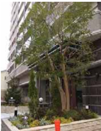
【写真】緑化事例（西区）
