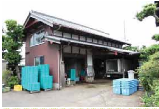
【写真 2】作業場兼倉庫（戸塚区）
