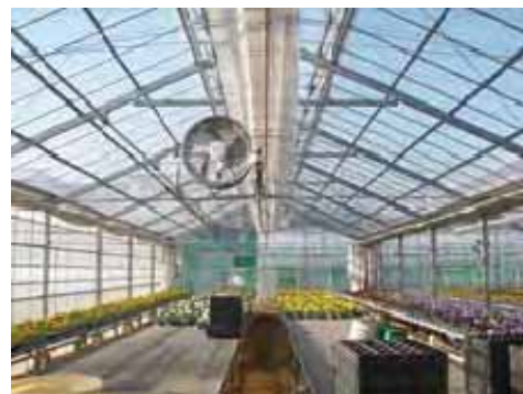
【写真】循環扇を設置した温室
