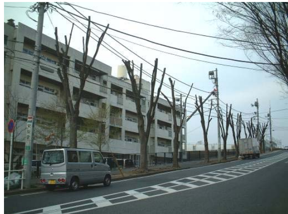
【写真】「ぶつ切りせん定」の事例 (ケヤキ)
