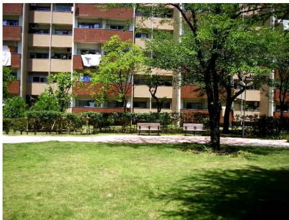
【写真】建築物緑化保全契約を締結した緑地の例 (集合住宅、南区)
