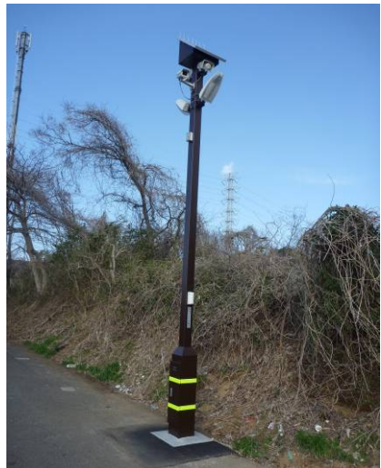
【写真】不法投棄監視警報装置の様子 (都筑区)
