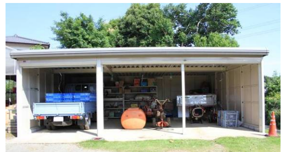
【写真】農業機械格納庫（泉区）
