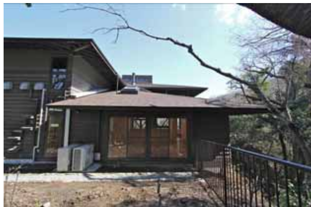
【写真】自然観察センター増築箇所
