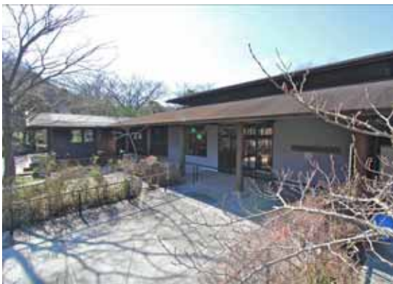
【写真】自然観察センター改修後の全景
