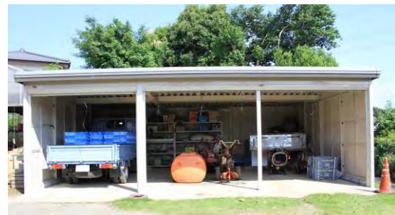
【写真】農業機械格納庫（泉区）
