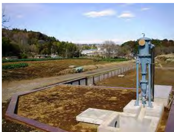
【写真】井戸及び配管整備 (緑区、向原地区畑地かんがい組合)
