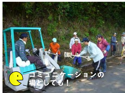
【写真 2】農業者団体による水路清掃 (5月開催、金沢区)
