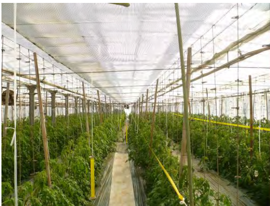
【写真】保温カーテンを設置した温室
