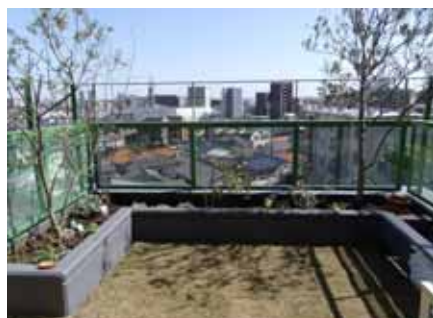
写真 屋上緑化助成事業 （施工後の様子）
