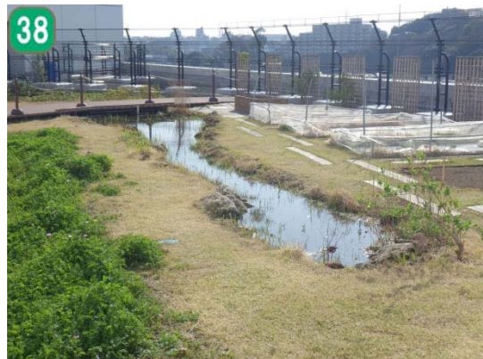
公共施設緑化管理事業（戸塚区総合庁舎）
