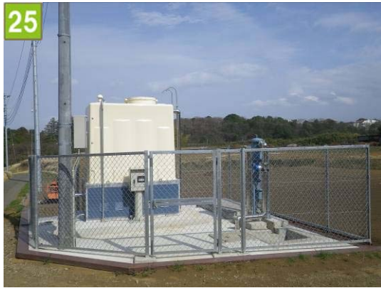
25 かんがい施設整備事業[井戸及び配管整備]（新治町）
