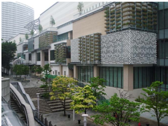
【写真】商業施設の壁面を緑化 （西区/みなとみらい21中央地区）
