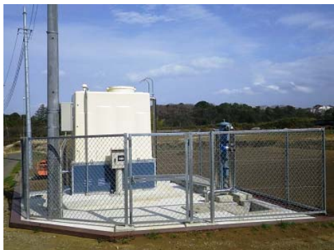
【写真】井戸及び配管整備 （都筑区東方町、向原地区畑地かんがい組合）
