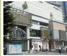
商業施設の壁面緑化の様子(西区)
