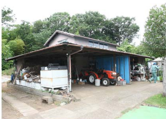
【写真 1】農業機械格納庫（戸塚区）
