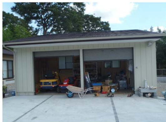
【写真 2】農業用倉庫（旭区）
