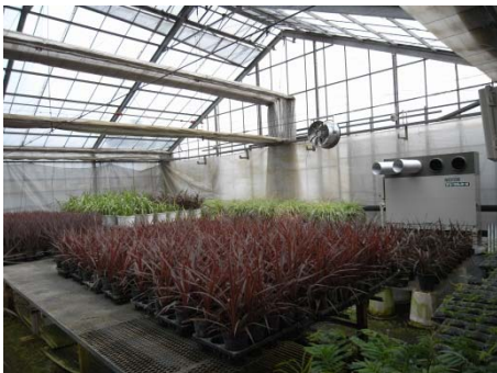
【写真】ヒートポンプを設置した温室
