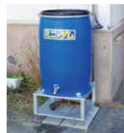
雨水タンクの設置
