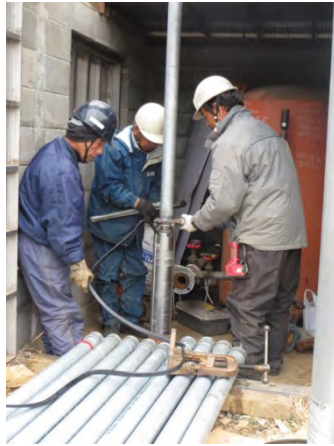
農業用の井戸からポンプで地下水を汲み上げます。 (写真はポンプの更新工事の様子)
