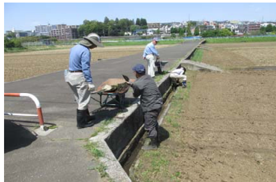
水路の維持管理作業(緑区いぶき野)
