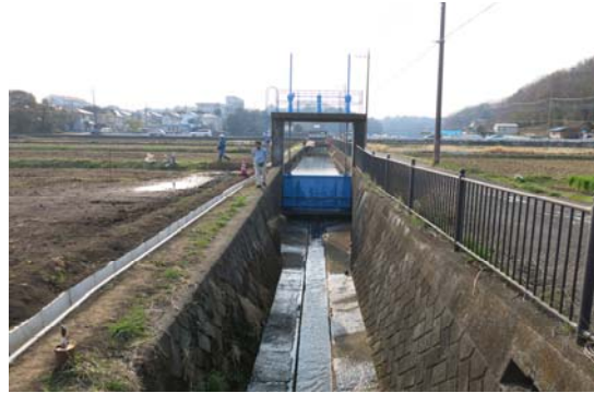
整備された水路(青葉区寺家町)
