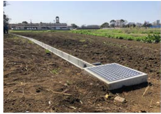
整備された水路(泉区下飯田町)
