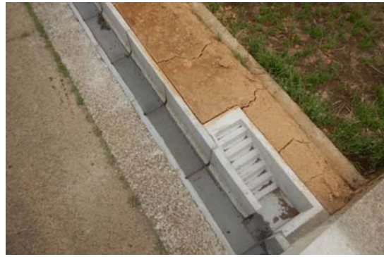
整備された水路(青葉区田奈町)
