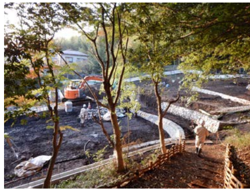
農園付公園 整備の様子 （大柵杉の森ふれあい公園：都筑区）
