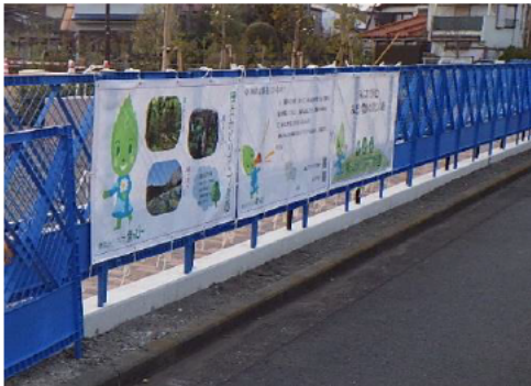
工事現場での現地表示
