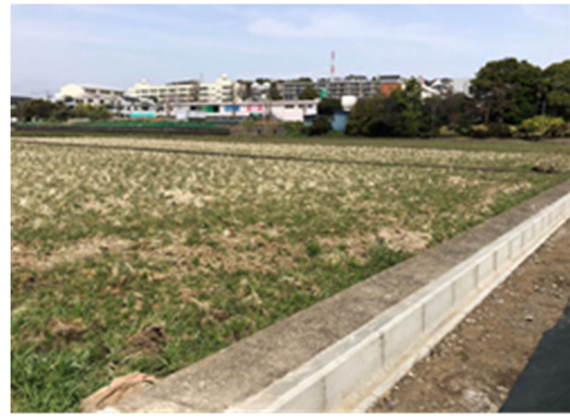
水田の用水路の更新(青葉区恩田町)
