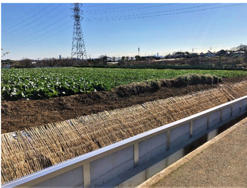
土砂流出防止対策を実施した農地 (都筑区東方町)
