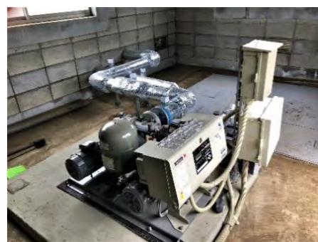
【改修を行ったポンプ施設】（戸塚区）
