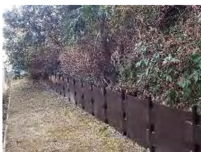
【土留めの設置】 大曾根台特別緑地保全地区 （港北区）
