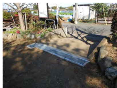
【側溝の整備】 鴨居原市民の森（緑区）
