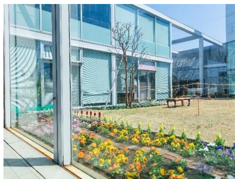
下和泉地区センター（泉区）
