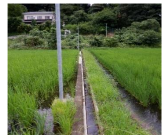
【改修した水路】（青葉区）
