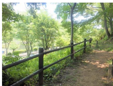
【安全確保のための柵の整備】 もえぎ野ふれあいの樹林（青葉区）
