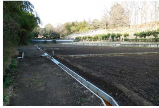
整備された水路(青葉区奈良町)
