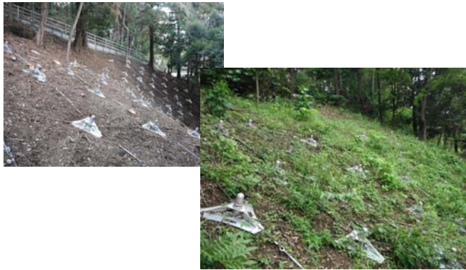
生物多様性にも配慮した防災や安全性の対策工事を行った法面(保土ヶ谷区／川島特別緑地保全地区)
